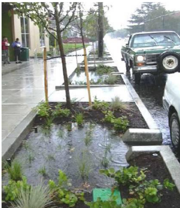
Figura 240 – Canteiro pluvial recebendo água de via pública, em Portland, E.U.A (CORMIER e PELLEGRINO, 2005, p.131).
