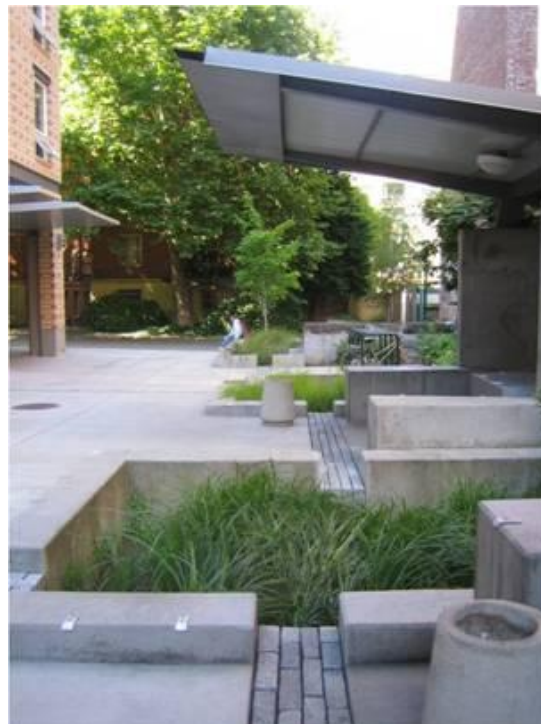
Figura 240 – Canteiro pluvial recebendo água de via pública, em Portland, E.U.A (CORMIER e PELLEGRINO, 2005, p.131).
