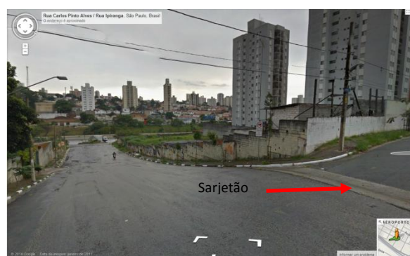
Figuras 127, 128 e 129 – Caminho das águas pluviais no Jardim Aeroporto, localizado nas encostas da bacia da Água Espreada, em São Paulo. As vias locais contam com guias, sarjetas e sarjetões, que conduzem as águas pluviais por gravidade para a Avenida Jornalista Roberto Marinho, no vale. Valeta protegida por grelha recolhe parte das águas da enxurrada, evitando que invadam a avenida. Imagens obtidas no Google Earth em 12/03/2014 e confirmadas no Apêndice C.
