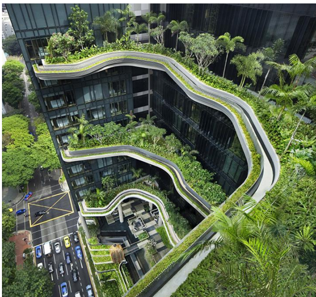
Figura 239 – Canteiros pluviais em sacadas no Hotel Park Royal, em Singapura. (WOHA, 2013).
