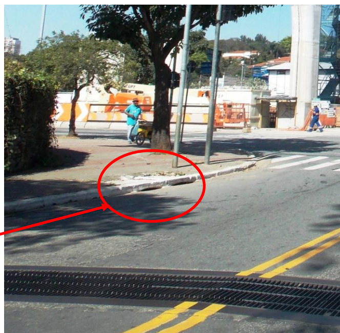
Figuras de 294 a 298 – Em sentido horário a partir da esquerda: valeta, sarjetão, grelha, bocas de lobo, sendo que esses dois últimos equipamentos somente são encontrados na baixada. Fotos da equipe Unib tomadas em 23/08/2014.
