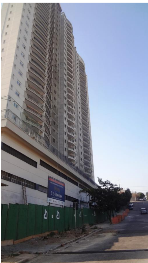
Figura 315 (acima)- Edifício residencial na encosta, com alguma vegetação no recuo gradeado. Observe-se sistema tradicional de drenagem. Foto tomada pela Equipe Unib em 30/08/2014.
