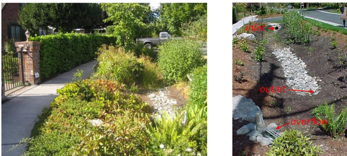
Figura 137 – Célula de biovaleta com bacia de sedimentação ajardinada numa das primeiras implantações desse tipo, dentro do projeto Street Edge Alternatives (SEA), em Seattle. (CORMIER e PELLEGRINO, 2010, p. 133).
