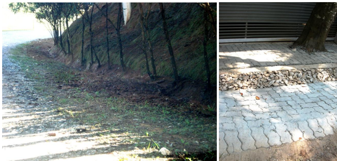
Figura 245 – Vala em terra para escoamento de águas pluviais, em via de pouco movimento em loteamento residencial de padrão nobre afastado do centro urbano, com leito carroçável em terra batida e pedriscos, sem passeio para pedestres. Fonte: Acervo da autora, 2012, Santa Lúcia, Carapicuíba-SP.
