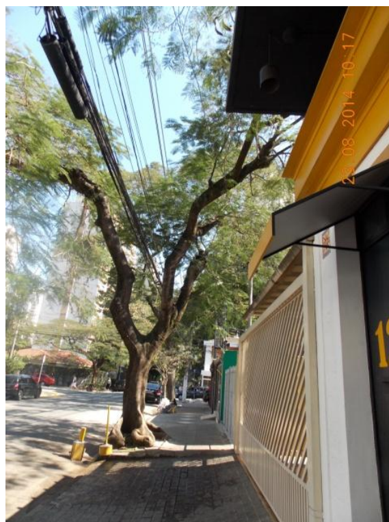
Figura 176 – Conflito entre infraestrutura aérea e arborização. Foto da equipe Unib tomada em 23/08/2014.
