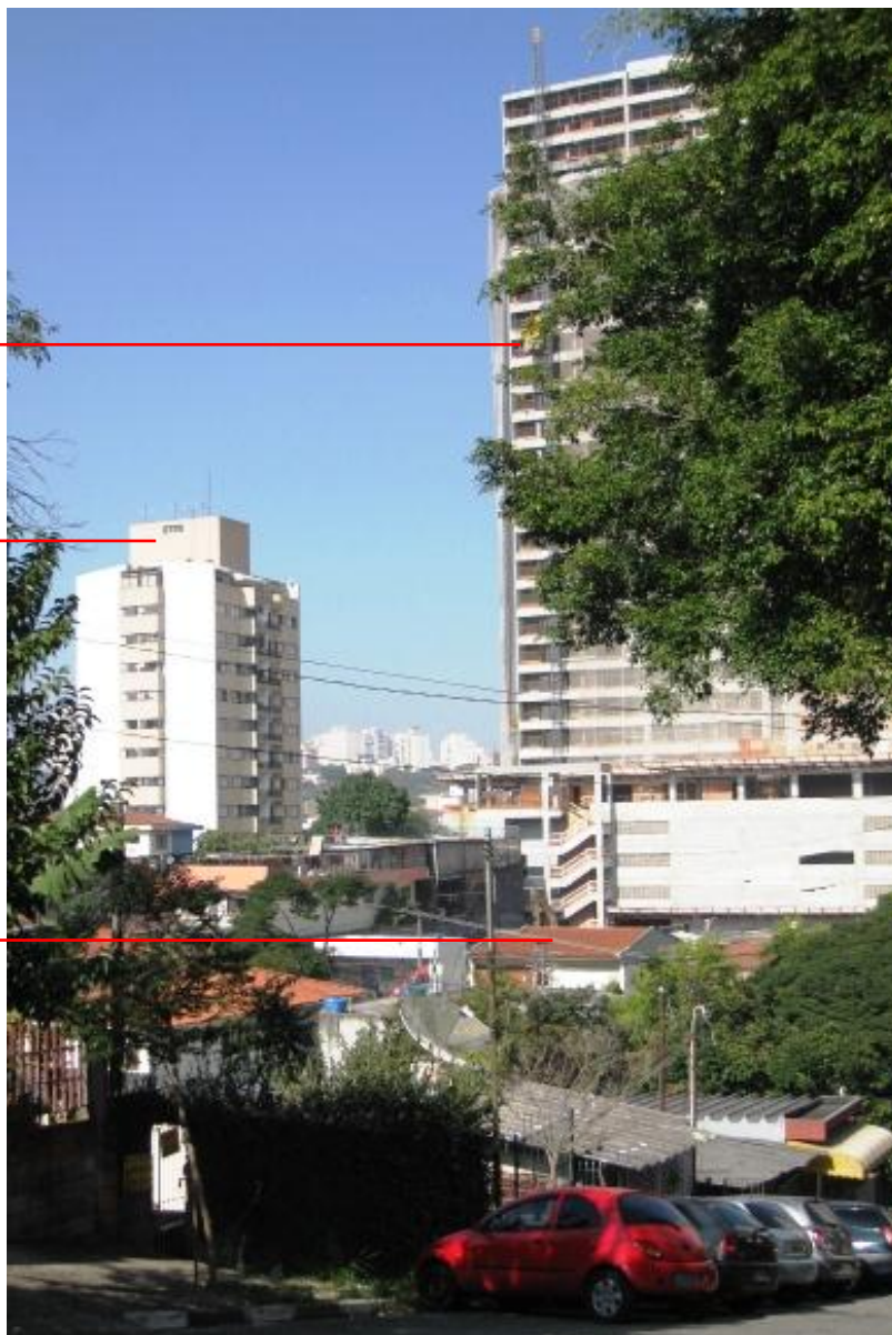
Figura 72 – Gerações de edifícios no Jardim Aeroporto. Intervenção da autora sobre fotografia de 22/07/2014, a partir das imediações das ruas Vapabuçu e Visconde de Outém, em direção a Vila Paulista.
