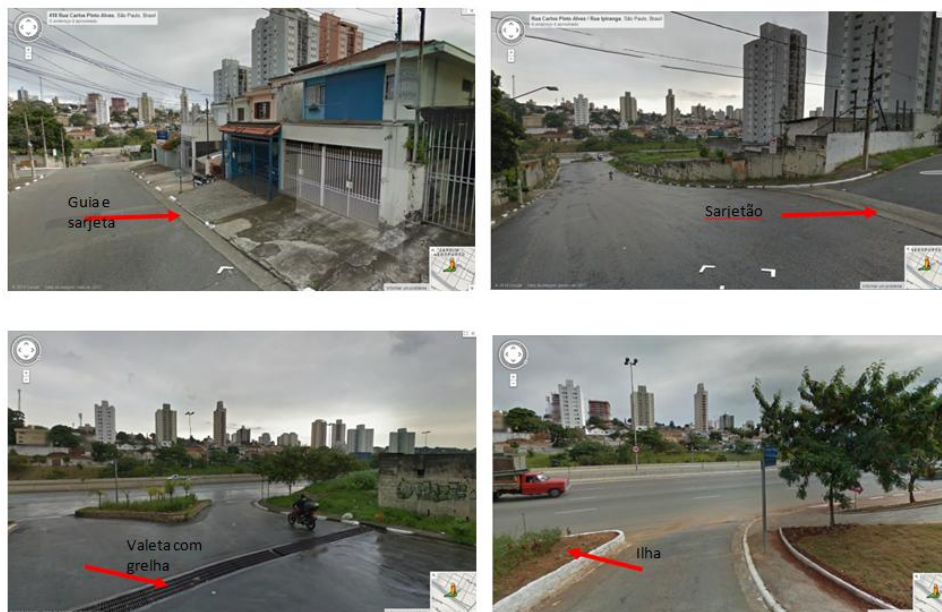
Figura 193 – Conjunto de imagens relativas ao eixo de pesquisa, apresentadas no Capítulo 5, ilustrando equipamentos tradicionais de drenagem pluvial.
