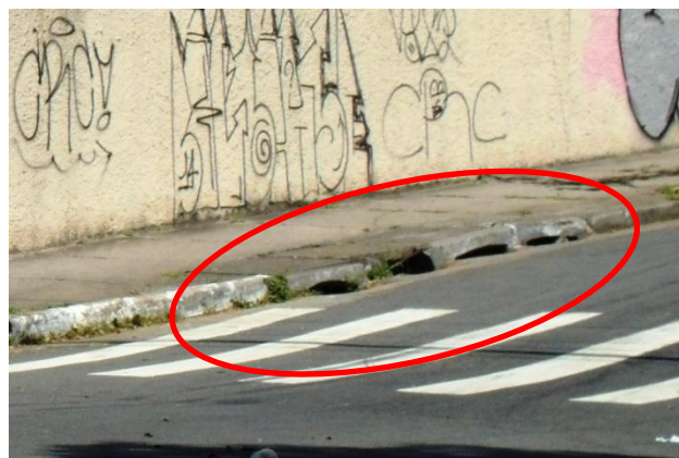
Figuras 336, 337 e 338 - Sistema tradicional de drenagem reforçado com bocas de lobo na encosta. Fotos tomadas pela Equipe Unib em 24/08/2014.
