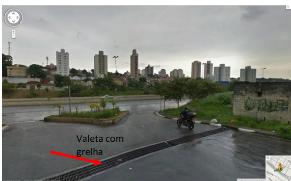
Figuras 127, 128 e 129 – Caminho das águas pluviais no Jardim Aeroporto, localizado nas encostas da bacia da Água Espreada, em São Paulo. As vias locais contam com guias, sarjetas e sarjetões, que conduzem as águas pluviais por gravidade para a Avenida Jornalista Roberto Marinho, no vale. Valeta protegida por grelha recolhe parte das águas da enxurrada, evitando que invadam a avenida. Imagens obtidas no Google Earth em 12/03/2014 e confirmadas no Apêndice C.
