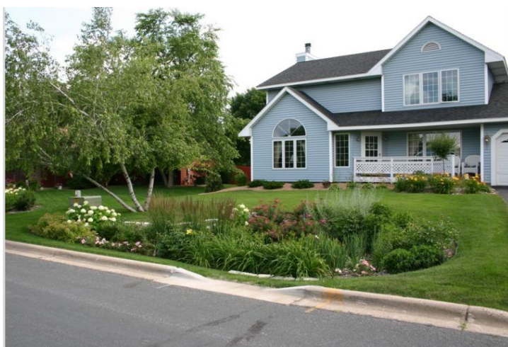
Figura 244 – Residência em Lafayette, região de Los Angeles, EUA, com jardim de chuva típico. Observar rebaixo da guia para penetração da água provida da via. (UNITED STATES ENVIRONMENTAL PROTECTION AGENCY, s/ data).
