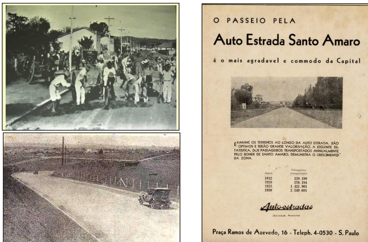
Figura 32 – Foto de agosto de 1936, com operários na construção da autoestrada de São Paulo para Santo Amaro. (FATORELLI, 2011).
