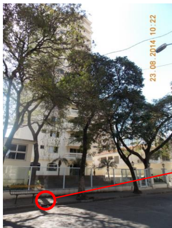
Figuras 299 e 300 e detalhes – O encaminhamento das águas pluviais para o sistema público é feito da mesma maneira por lotes isolados e por condomínios, diretamente, sem inclusão de equipamentos que retardem o escoamento ou filtrem as águas. Fotos da equipe Unib tomadas em 23/08/2014.
