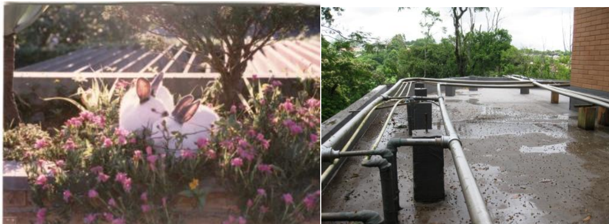
Figura 233 – Jardim em laje de cobertura de residência no Jardim Prudência, São Paulo, construída com substrato de terra, lençol de material não-tecido, grânulos de diâmetros diversos, para filtragem da água e encaminhamento para o sistema de drenagem pluvial e de lavagem. Projeto e execução da autora, em 1980, ainda em funcionamento. Fonte: Arquivo pessoal.
