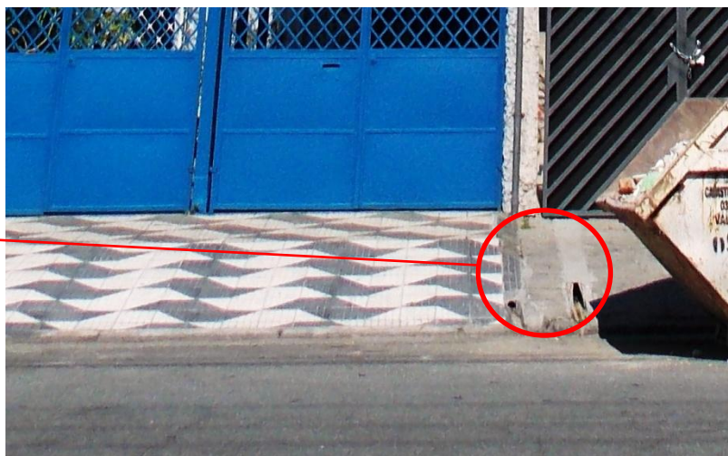
Figuras 299 e 300 e detalhes – O encaminhamento das águas pluviais para o sistema público é feito da mesma maneira por lotes isolados e por condomínios, diretamente, sem inclusão de equipamentos que retardem o escoamento ou filtrem as águas. Fotos da equipe Unib tomadas em 23/08/2014.
